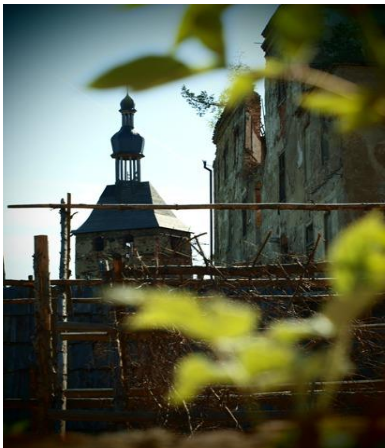
Obr. č. 45: Hrad Hartenberg – probíhající rekonstrukce
