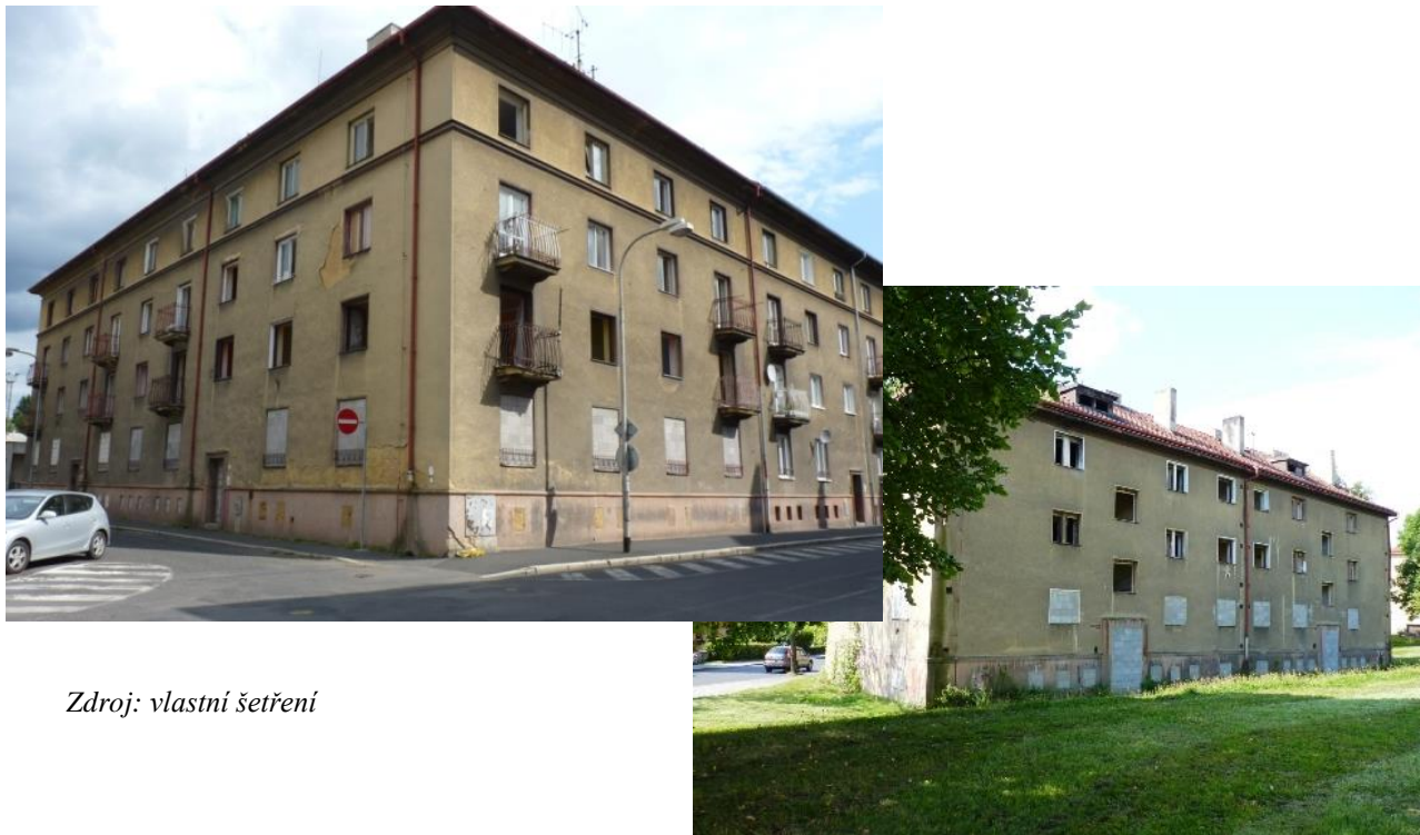
Obr. č. 13: SVL ul. Sokolovská a U Divadla v Sokolově
