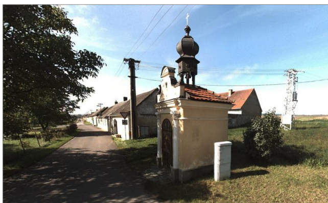
Obr. 76: Necitlivé umístění zařízení nezbytných pro inženýrské sítě má dopad na vzhled a charakter sítěmi obsluhované části vesnice. Nové Kestřany (okr. Písek).
