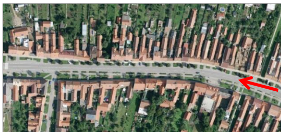
Hluk (okr. Uherské Hradiště).
