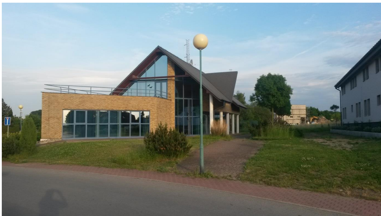
Obr.: Současný stav administrativní budovy
