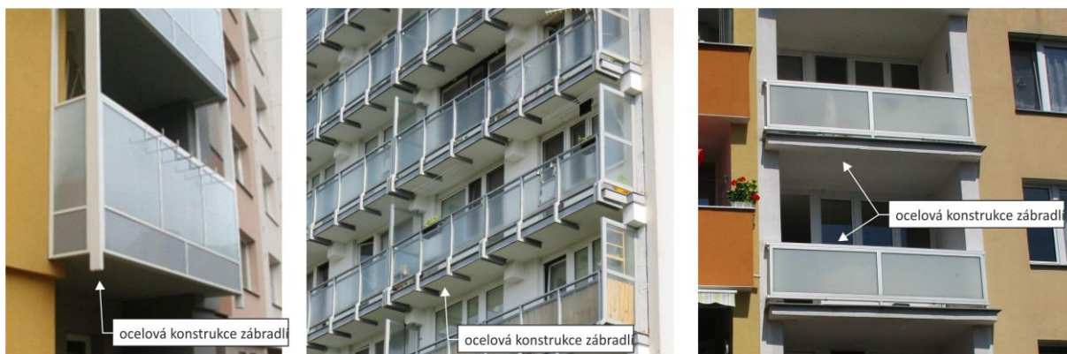
Obr. 56 Příklady provedení ocelových zábradlí jako samostatných zámečnických prvků osazovaných v průběhu dokončovacích prací
