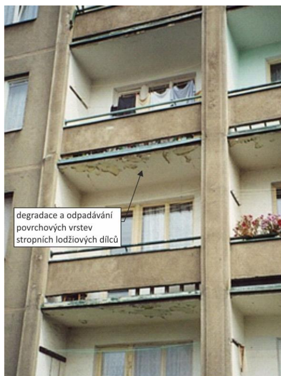
Obr. 7 a) Porušené podlahy a okapní plochy na lodžiových stropních dílcích (stavební soustava G57) – degradace a odpadávání povrchových a krycích vrstev stropních lodžiových dílců, b) Detail řešení styk obvodového pláště s nosnou konstrukcí
