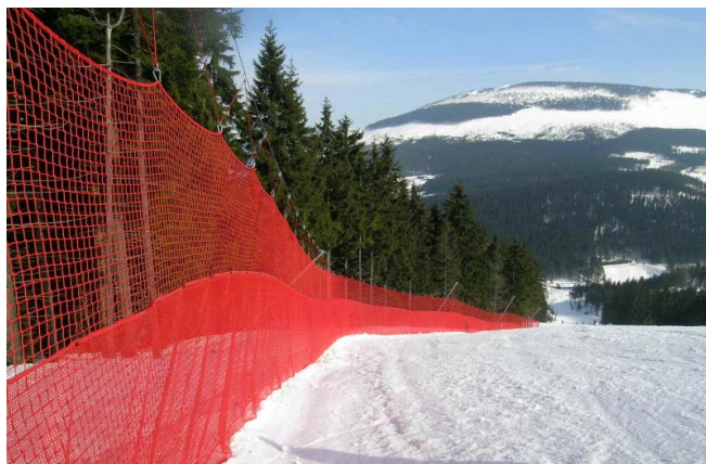
Obrázek 14 – Příklad zajištění bezpečnosti provozu A-FIS sítě
