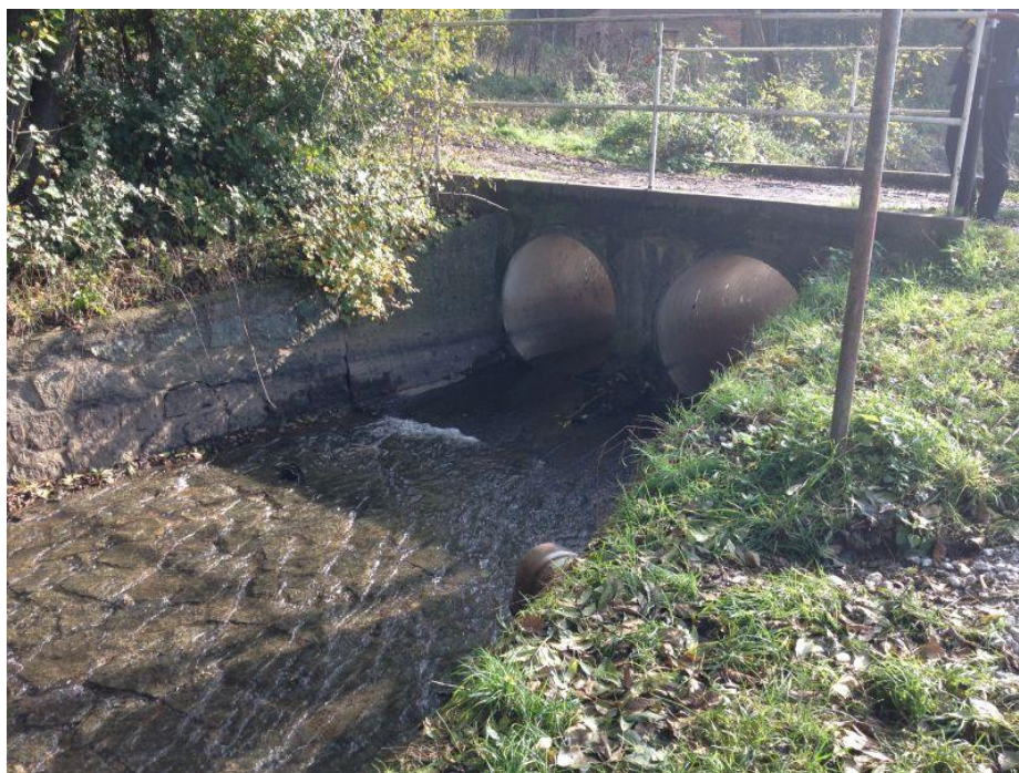
Obr. 8 - Propustek DN 1000 v místní části Halouny
