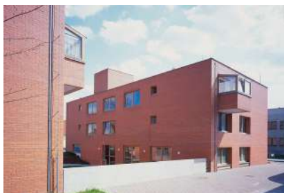
Obr. / 57 Nadčasová fasáda domu z kvalitních materiálů
