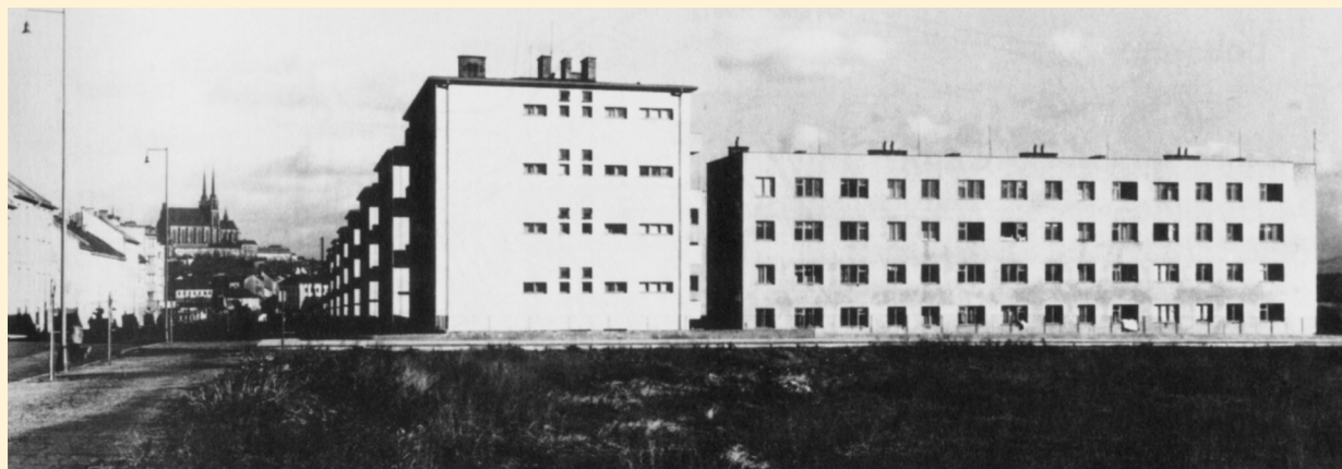
Bedřich Rozehnal: městské nájemné domy s malými byty, 1936–1937, ul. Renneská, Brno
