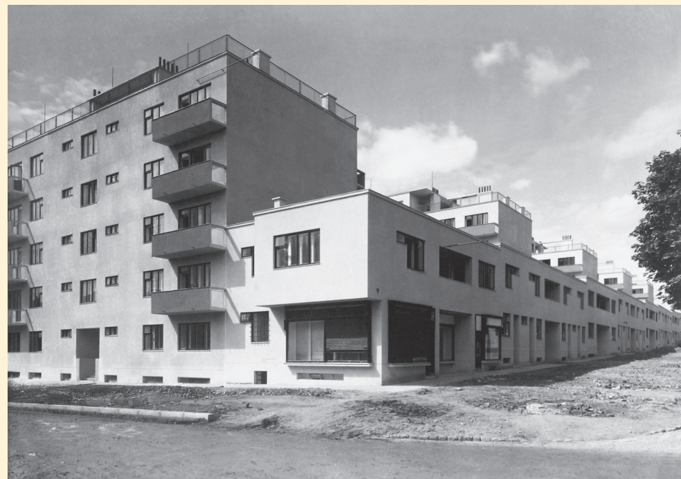
Josef Polášek: malobytová kolonie města Brna, 1931–1933 ul Skácelova, Brno-Královo Pole
