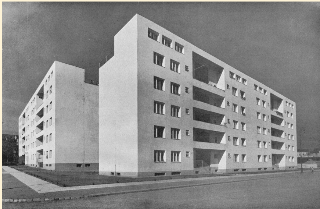
Josef Polášek: soubor nájemných domů s minimálními byty, 1930–1932, ul. Vranovská, Brně-Zábřevicích
