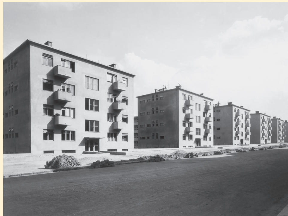
Bedřich Rozehnal: městské nájemné domy s malými byty, 1936–1937, ul. Renneská, Brno
