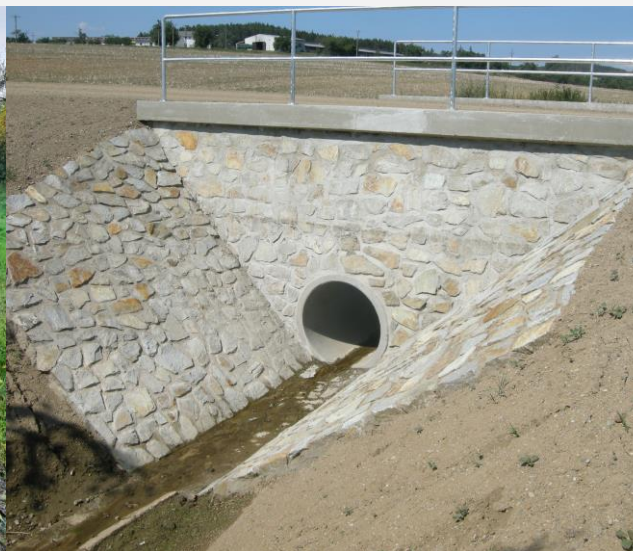
Pb Třebíč, Čechočovice, C5 s propustkem v průběhu realizace
