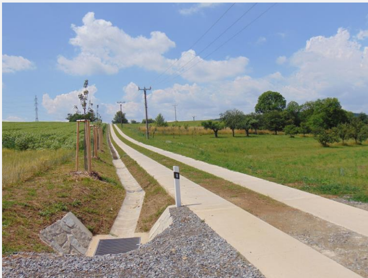
Pb Brno, Moravské Knínice, polní cesta C17
