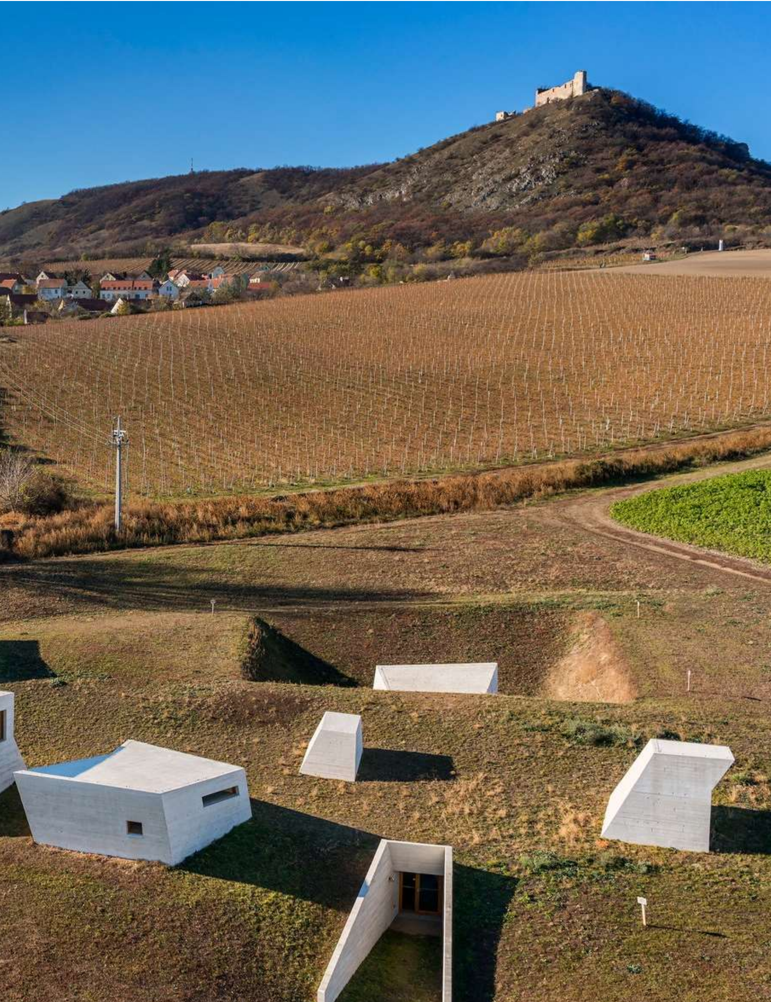
Obr. 7 – Archeopark Pavlov. Hlavní cena České ceny za architekturu 2017. Pavlov. Autor: Ing. arch. Radko Květ, Ing. arch. Pavel Pijáček. Fotografie: Ales Jungmann. Pozornost si zaslouží zejména začlenění díla současné architektury do krajinného rázu místa s hlubokou vazbou na přírodu, kulturní i historické dědictví a hodnotu krajiny Pálavy a jejího okolí.
