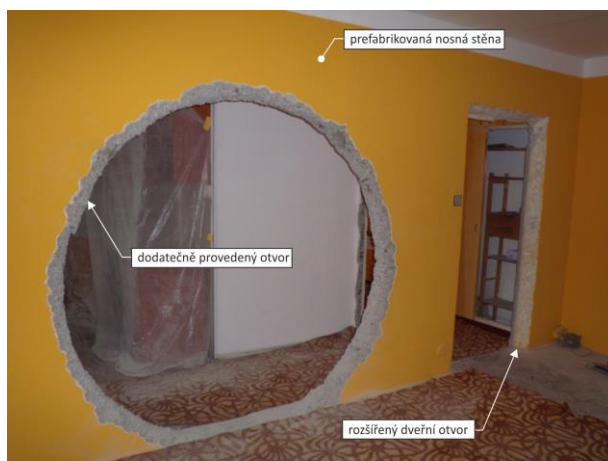
Obr. 49 Ukázka oslabení nosné stěny kruhovým otvorem průměru 2m a dalším dveřním otvorem (Witzany et al., 2014)
