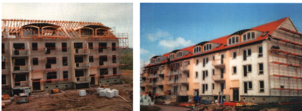
Obr. 57 Panelový dům po demontáži horních podlaží, opatřený šikmou střechou a zateplením obvodového pláště
