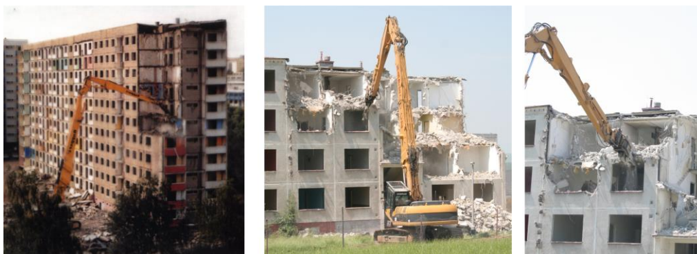
Obr. 56 Demolice deskového panelového domu
