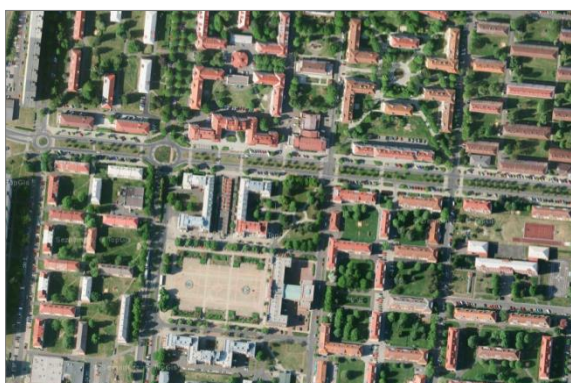
Obr. 3: Sídlištní výstavba z 60. let 20. století ve stylu socialistického realismu je typická zelenými vnitrobloky a geometricky pravidelnými ulicemi. Ostrov, okres Karlovy Vary.
