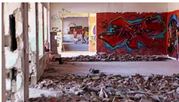
Obr. 5 – Fotografie z rekonstrukce Piazza de Curtis. Foto Dario Chiocca
