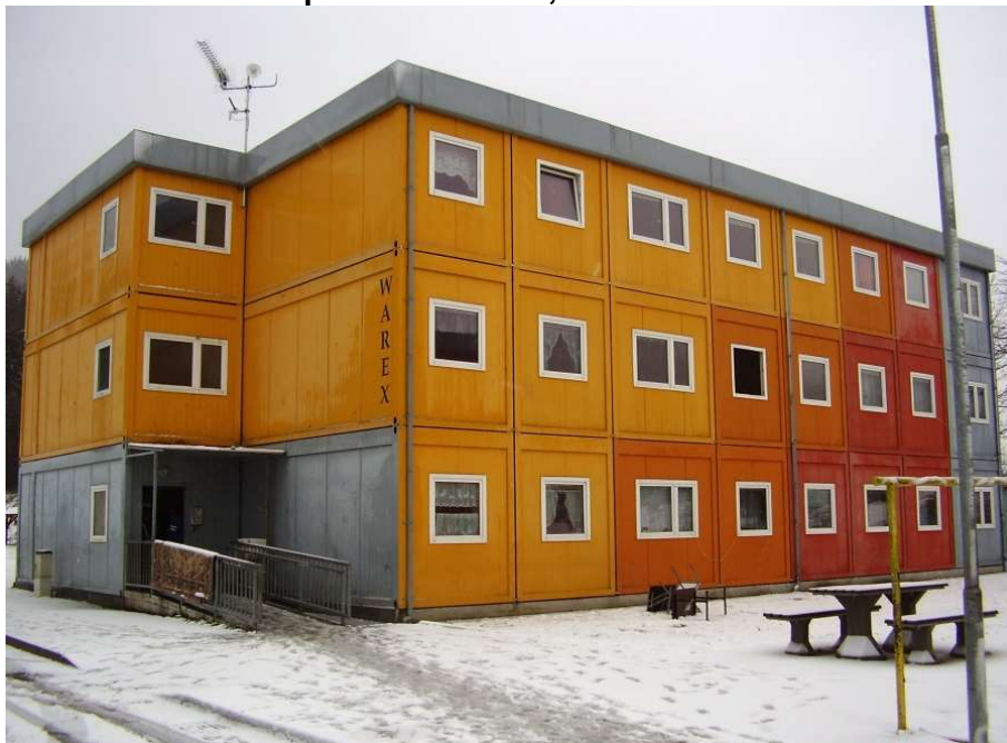
Obrázek 3 – dům č.p. 2083 Poschla, Vsetín
