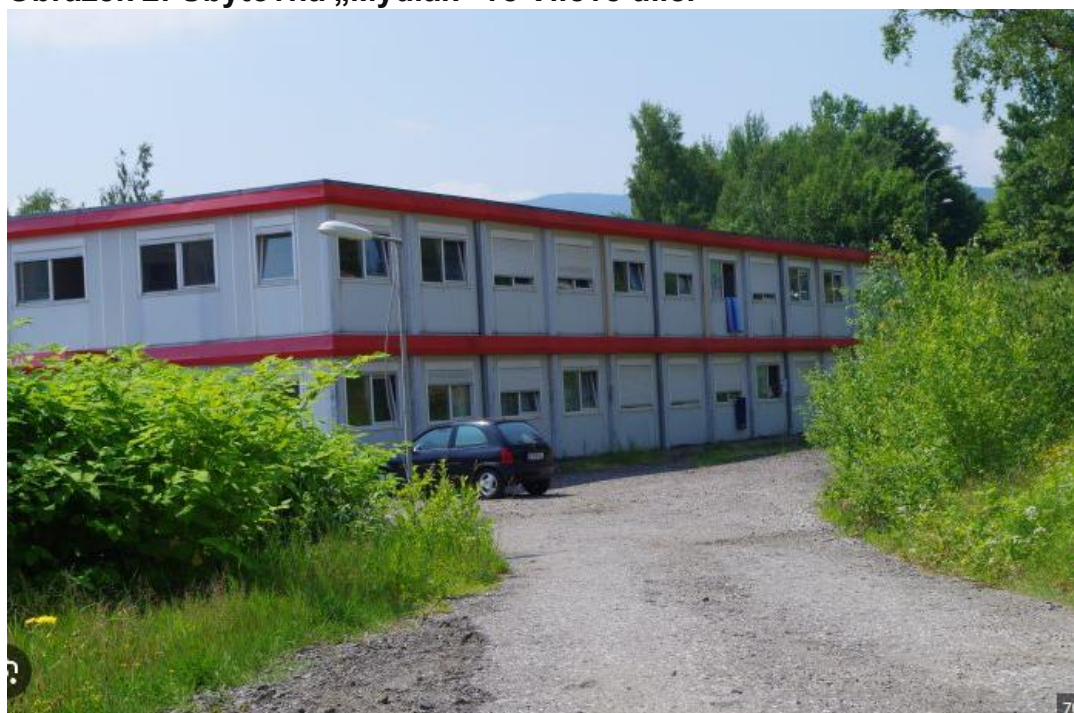
Obrázek 2: Ubytovna „Mydlák“ ve Vilové ulici
