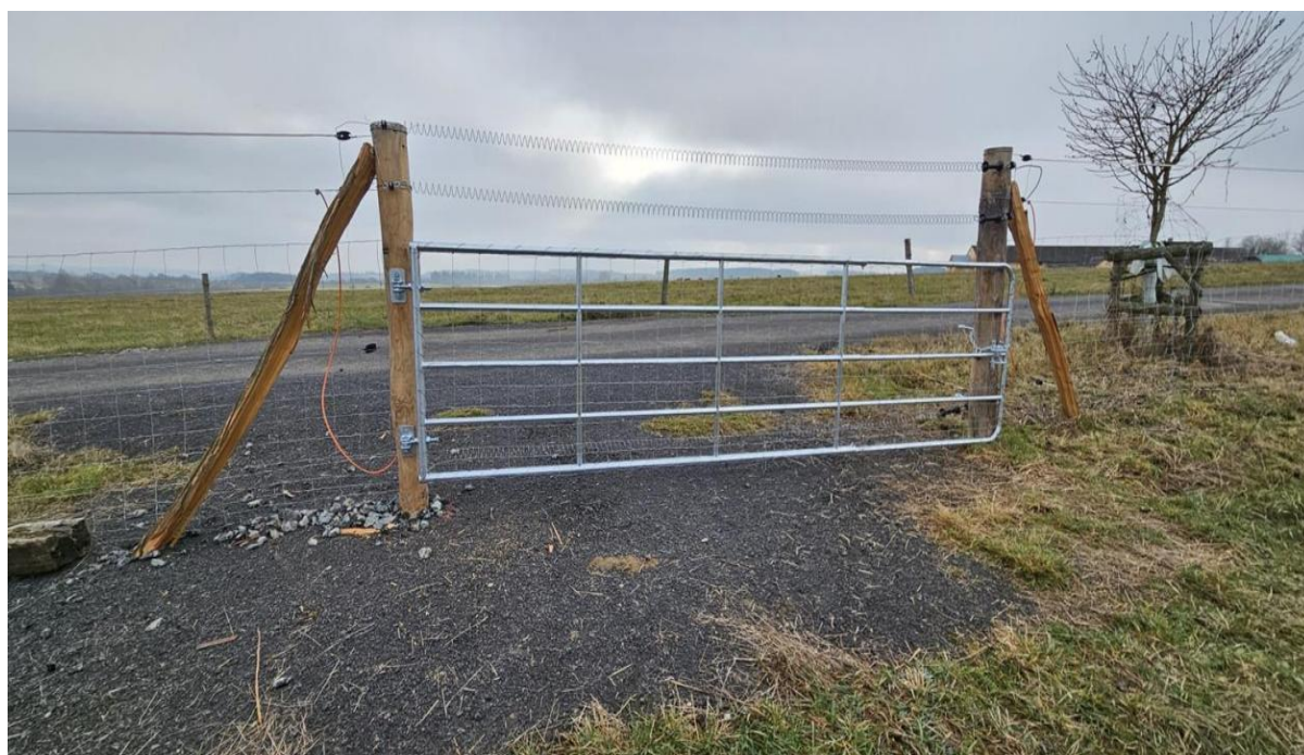
Ohrada s pletivem a elektrickým páskem ohradníku s celokovovou bránou opatřenou pružinovým vodičem
