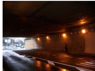
Tunel de Somport
