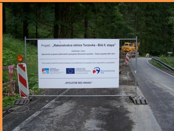
průběh rekonstrukce silnice
